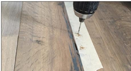
Percer un trou de 2 mm là où il n'y a pas d'adhérence entre la couche d'usure et la couche médiane (précaution: ne pas percer au-delà de l'épaisseur de la couche d'usure!)
