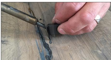
Colmater la fissure avec de la cire dure
