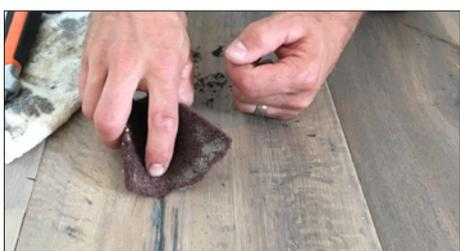
Retoucher la partie réparée avec un « pad » et procéder le cas échéant à un traitement ultérieur avec une huile d'entretien, respectivement une pâte d'entretien.
