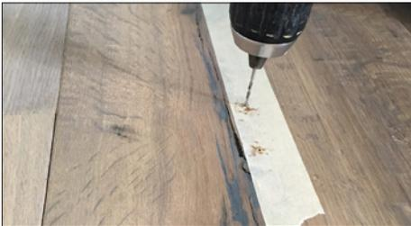
2 mm Loch bohren wo Decklage und Mittellage nicht haften. Achtung, Loch nur so tief bohren wie die Decklage stark ist!
