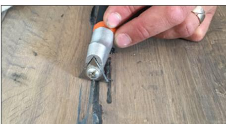
Überstehenden Hartwachs mit entsprechendem Werkzeug entfernen.
