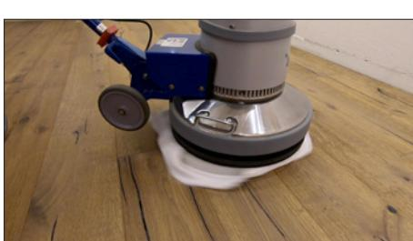
Nach max. 30 Minuten, je nach Raumklima, kann die Holzoberfläche mit einem trockenen, fuselfreien Baumwolltuch nachpoliert werden. Randpartien sollen mit dem Tuch von Hand nachgearbeitet werden.
