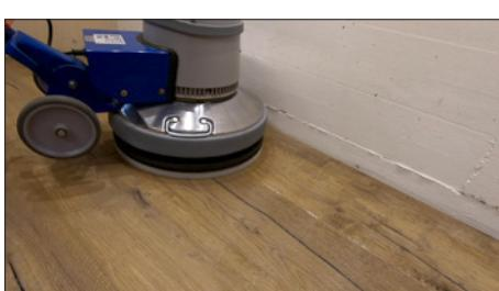
Kährs-Profiöl mit der Einscheibenmaschine und aufgesetztem weißen oder beigem Pad in Dielenrichtung einarbeiten.
